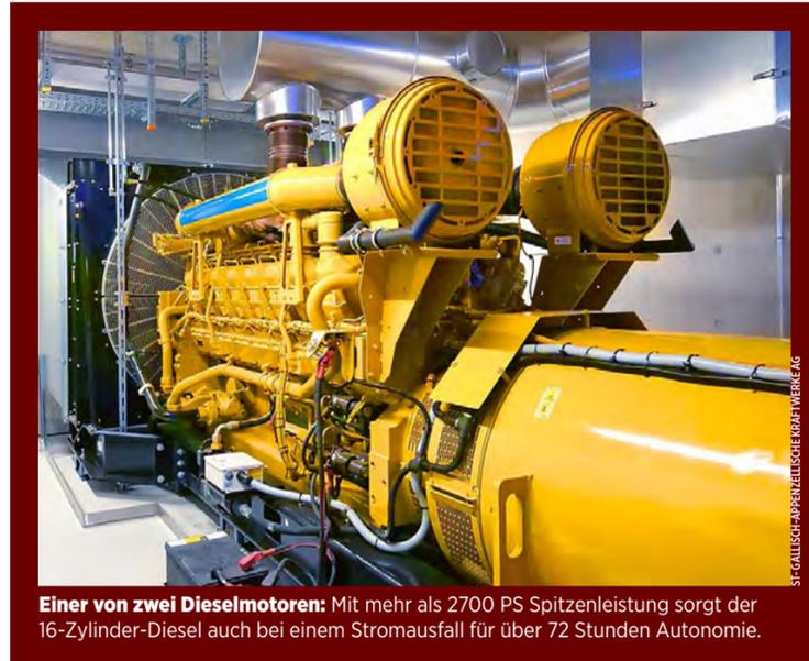
**Einer von zwei Dieselmotoren:** Mit mehr als 2700 PS Spitzenleistung sorgt der 16-Zylinder-Diesel auch bei einem Stromausfall für über 72 Stunden Autonomie.
